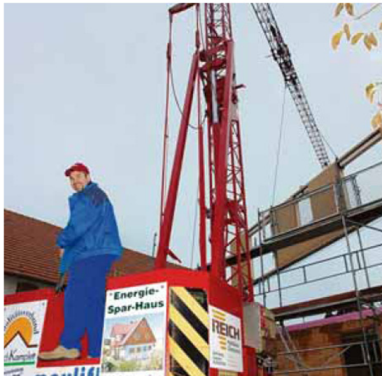
Holzbau ist mehr als nur Balken für einen Dachstuhl zusägen und einbauen. Thomas Reich von der Gaulzhofener Firma Reich GmbH Zimmerei-Holzbau hievt mit dem firmeneigenen Kran gerade eine im Betrieb zusammengebaute Wand passgenau in einen Wohn-Aufbau über einem Altbau.
